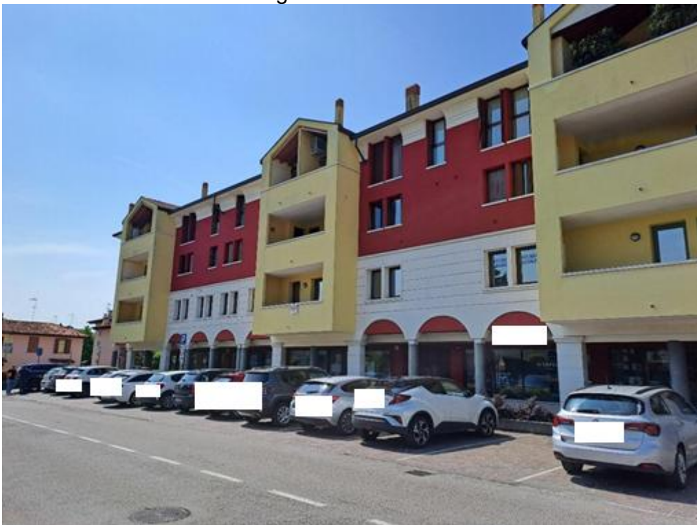
Vista generale da Nord-Ovest
